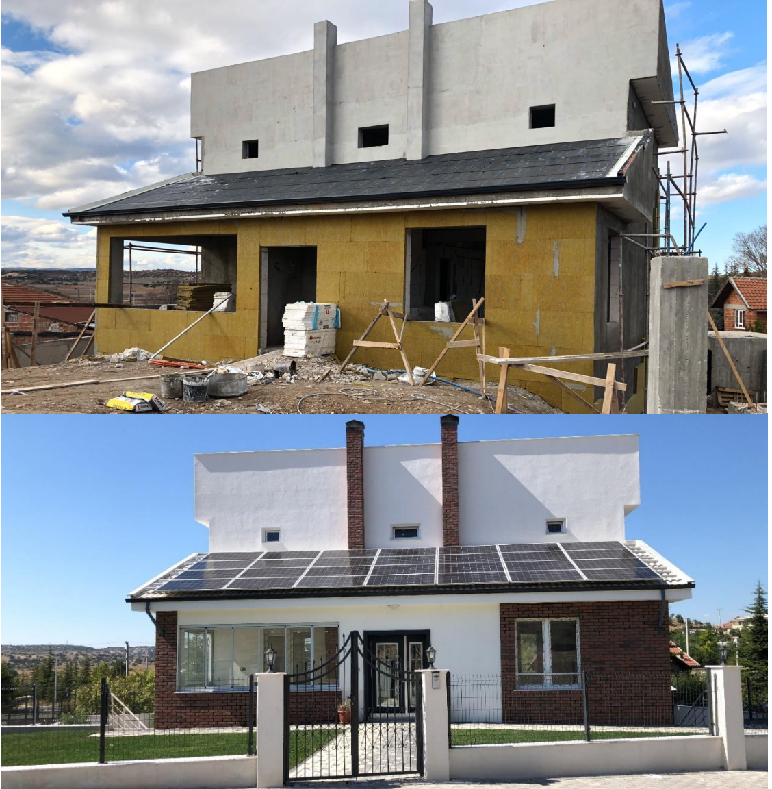
Görsel 2 Binaanın yalıtım süreci ve bitmiş hali
