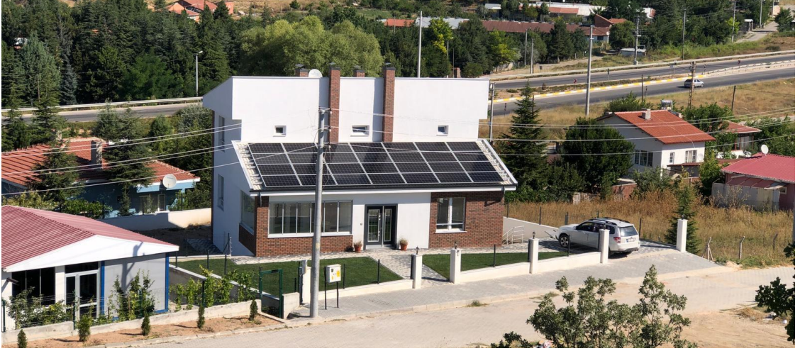
Görsel 16 28 adet PV panelin yerleşimi
