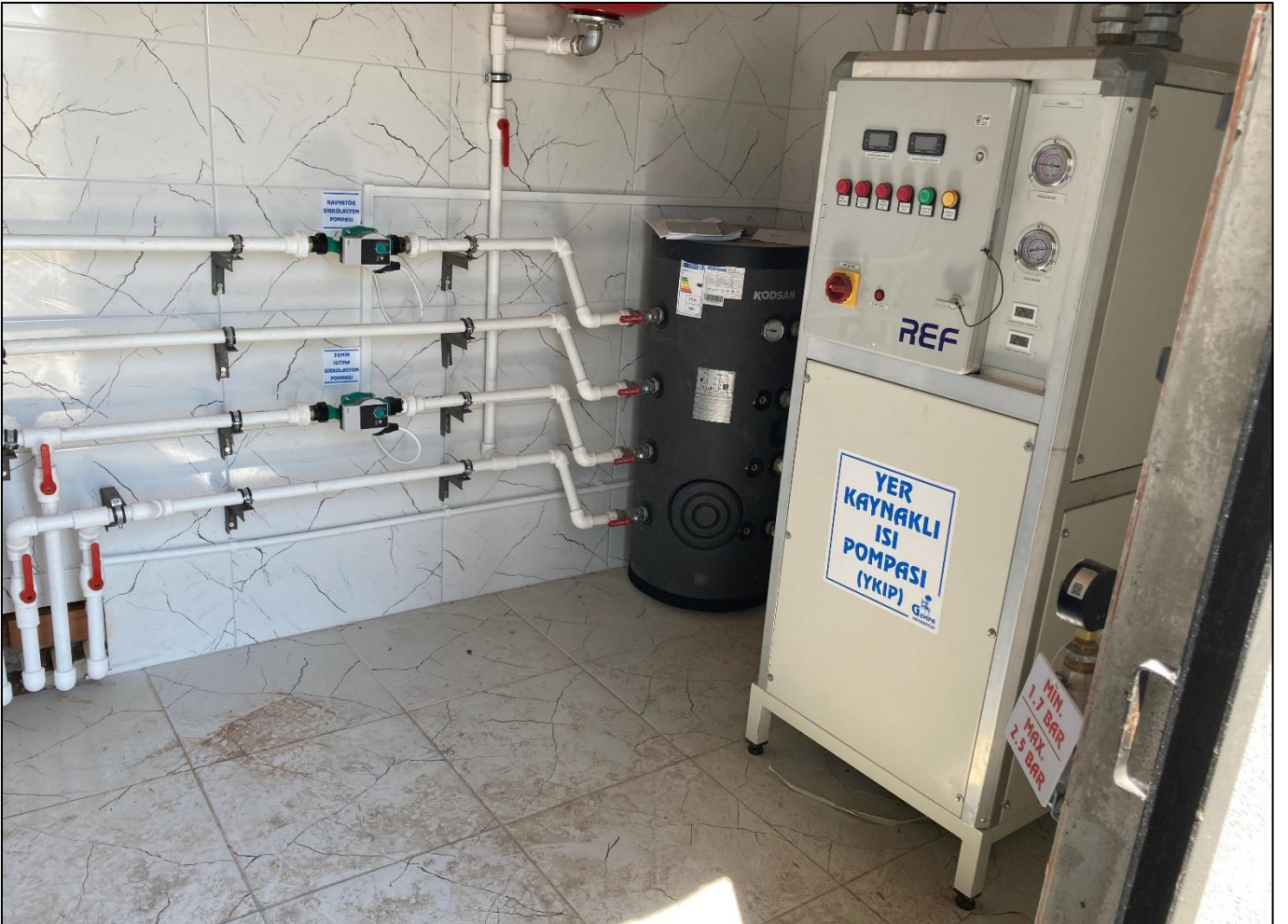
Şekil 1. YKIP kazan odası
