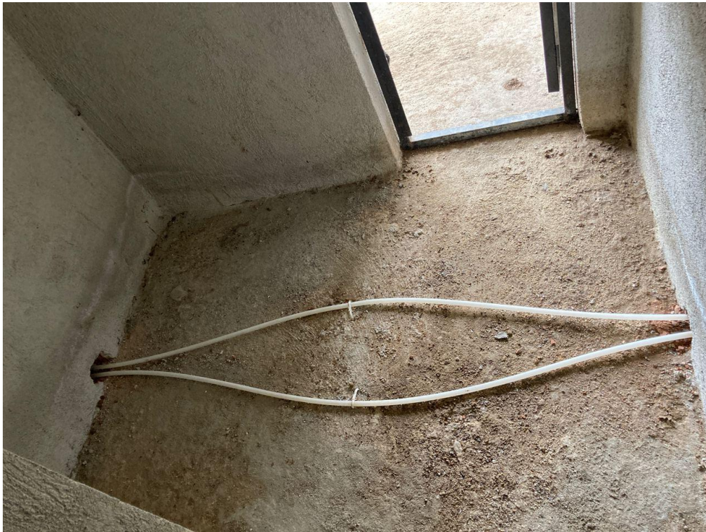
Görsel 1 YKIP ile ısıtılacak zeminden ısıtma boruları (26-10-2020)
